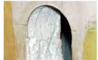
Fire retardant door insulation (friable)
